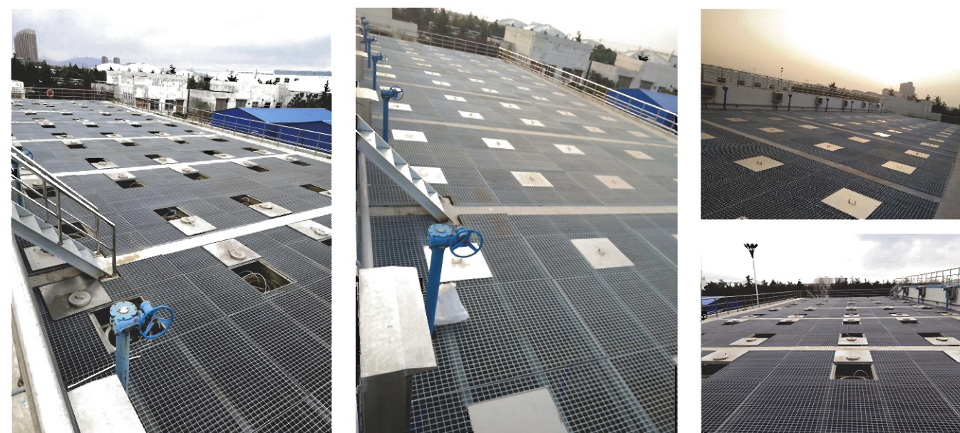
青岛黄岛中科污水厂处理厂 15万吨 活性砂过滤系统
