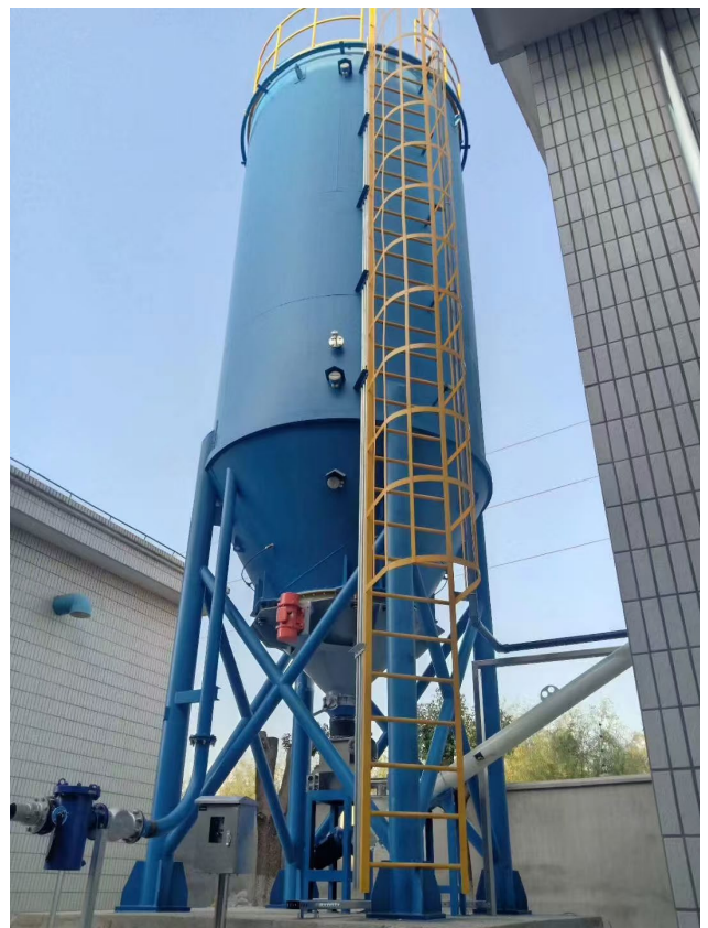
常州港武取水泵站
