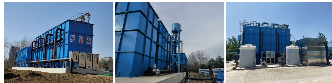
山东某污水处理厂 3000吨 硫自养反硝化滤池
