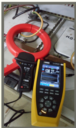
配合泄露钳表进行测量，并记录故障
