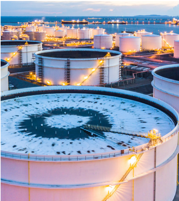
危化品储罐区
