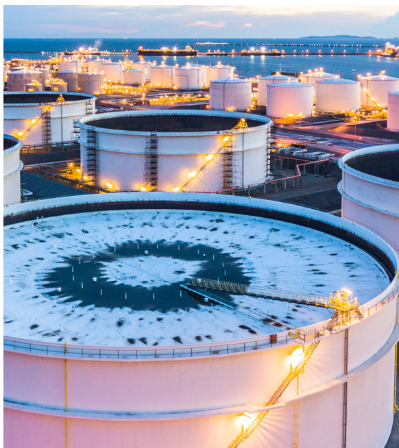
危化品储罐区
