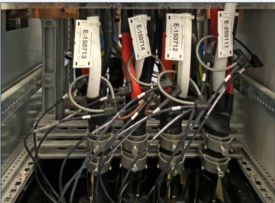
电流链路模块现场安装
