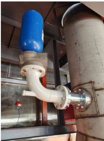
某生物科技公司无火焰泄爆及抑爆系统图纸设计示意图
