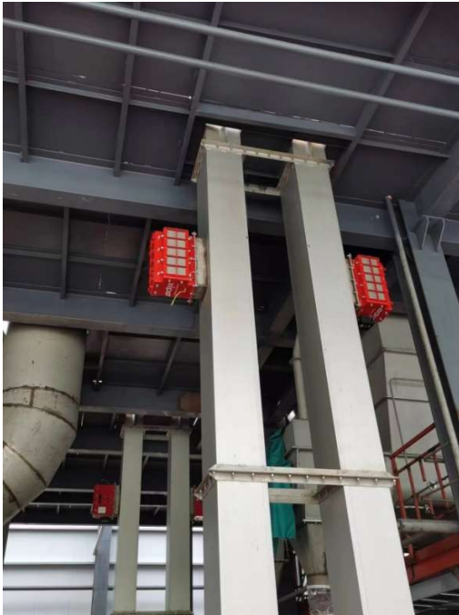
某生物科技公司无火焰泄爆及抑爆系统现场安装示意图
