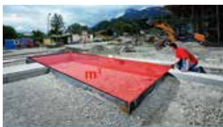
体积测量功能 直接测量方坑体积
