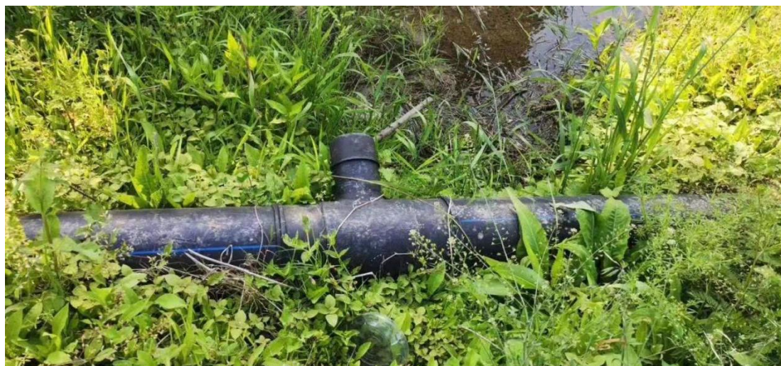
图 3 湖北仙桃某地双频雷达管线探测现场裸露管线
