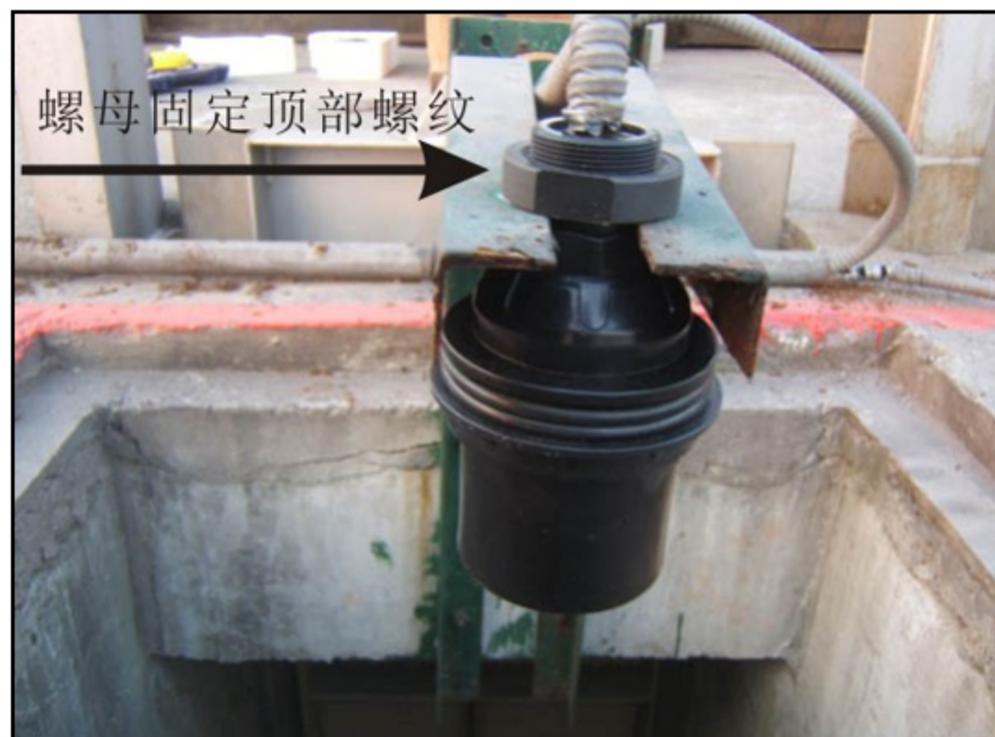
①在探头顶部螺纹用螺母固定 ②探头进线要用保护管
