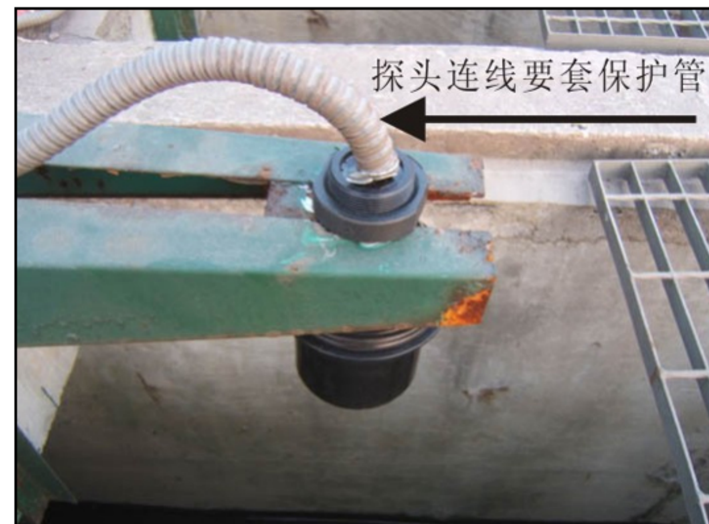
①在探头顶部螺纹用螺母固定 ②探头进线要用保护管
