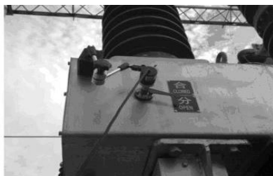
35KV SF6 开关传感器安装
