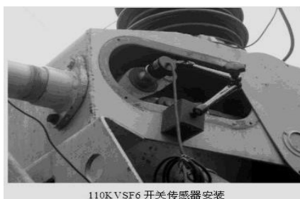
110KV SF6 开关传感器安装
