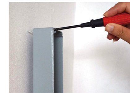
通过盒体的通孔用螺丝直接固定
