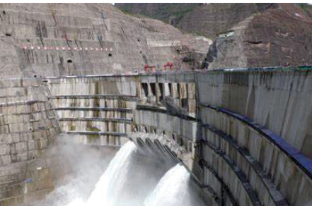
• 大坝监测 Dam monitoring
